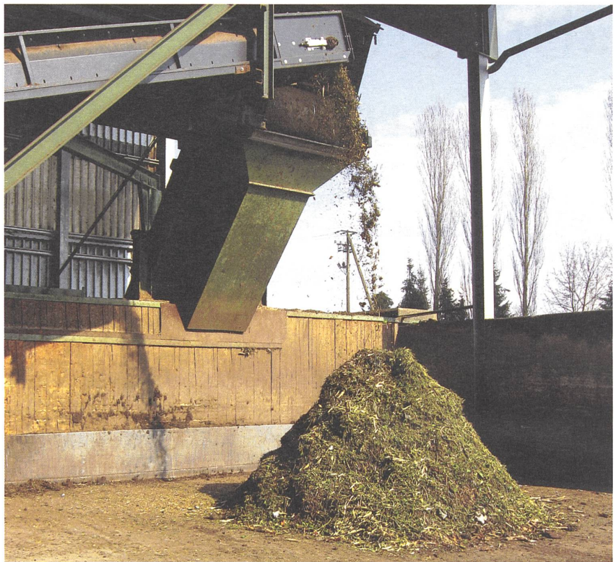
Die Kompostier- und Vergärungsanlage Allmig in Baar ist für ihn ein sinnvolles Beispiel...
