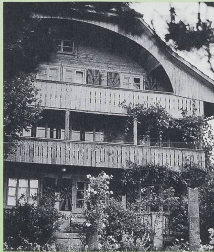
Am äusseren Aussehen des behäbigen Hauses wird sich durch den Umbau wenig ändern, wohl aber an der Wohnqualität.
