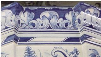
Abb.60 Detail zum Turmofen Abb. 59, Neuergänzung vom Kranzgesims. Unterglasurmalerei von Mina Allenspach-Egloff auf hochweisser Behautmasse, Zinndioxidhaltige Transparent-Glasur (FA). Foto J. B. Schreiber.
