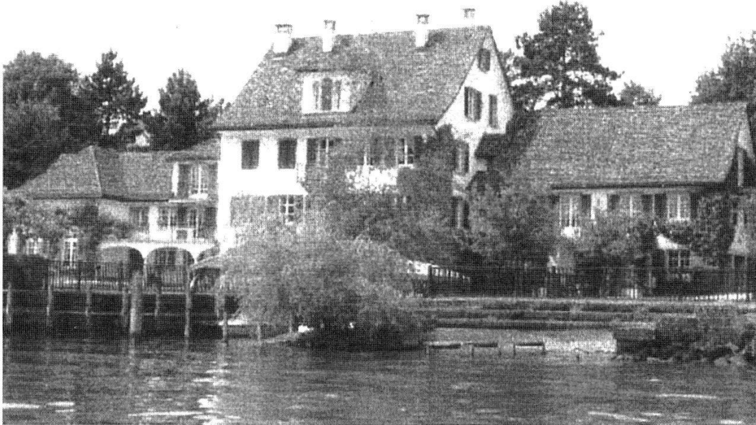
Gebäude der ehemaligen Porzellanmanufaktur in Kilchberg; vor der Sprengung
