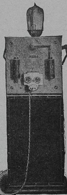
Der Quecksilberdampf-Gleichrichter Cooper Hewitt dient dazu, Wechselstrom in Gleichstrom umzuformen. Kostspielige Bedienung u. Unterhalt wie bei den rotierenden Umformern fallen dahin!
