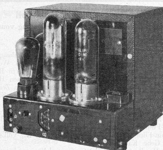
Die Felderregung der Lautsprecher erfolgt durch einen im Fuss des Projektors eingebauten Gleichrichter. Die Schaltung ist so eingerichtet, dass der Abhörlausprecher in der Kabine nur bei angeschlossenem Gleichrichter eingeschaltet werden kann. Es ist also unmöglich, dass der Operateur vergisst, die Saallautsprecher einzuschalten.
