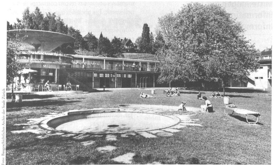
Strandbad Wollishofen, erbaut 1939 vom Stadtbaumeister Hermann Herter.
