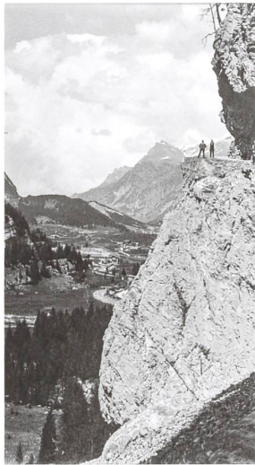
Die Strasse ist aus dem Fels gesprengt, noch fehlt die Brüstung. Frühling 1925. Foto Staatsarchiv des Kantons Bern
