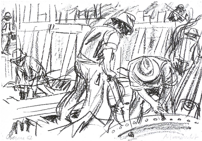
Die Künstler wohnen auf der Baustelle in Baracken und wollen den Helden der Arbeit ein Denkmal setzen – die interessieren sich allerdings wenig für die Kunst. (Rudolf Mumprecht: Kraftwerksbau an der Oberaar, 1952)
