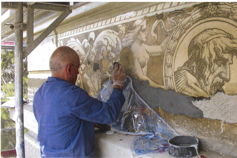
Abb. 12a/b Um die Sgraffiti dauerhafter zu sichern, wurden die Oberflächen 2003 mit Kieselsäure-ester hinterspritzt und zusätzlich mit der Schnabelflasche geflutet. Fehlstellen wie bei diesem Porträtmedaillon auf der Hauptfassade wurden mit grau gefärbtem Kalkmörtel ergänzt. © Kantonale Denkmalpflege Aargau, ZOF068-BE-2003-01/005, Bericht von Heinz Schwarz und Gertrud Fehring, 2005, Bild Nr.94 (oben) und Bild Nr.106 (unten)
