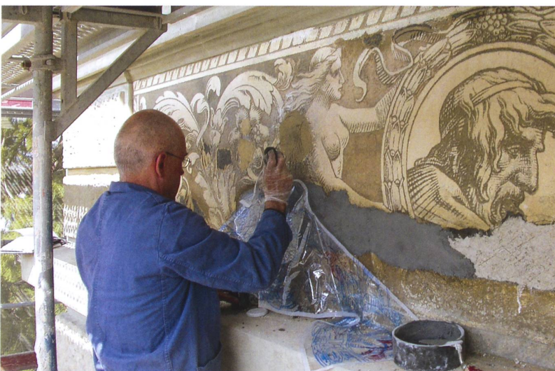
Abb. 12a/b Um die Sgraffiti dauerhafter zu sichern, wurden die Oberflächen 2003 mit Kieselsäure-ester hinterspritzt und zusätzlich mit der Schnabelflasche geflutet. Fehlstellen wie bei diesem Porträtmedaillon auf der Hauptfassade wurden mit grau gefärbtem Kalkmörtel ergänzt. © Kantonale Denkmalpflege Aargau, ZOF068-BE-2003-01/005, Bericht von Heinz Schwarz und Gertrud Fehrer, 2005, Bild Nr.94 (oben) und Bild Nr.106 (unten)
