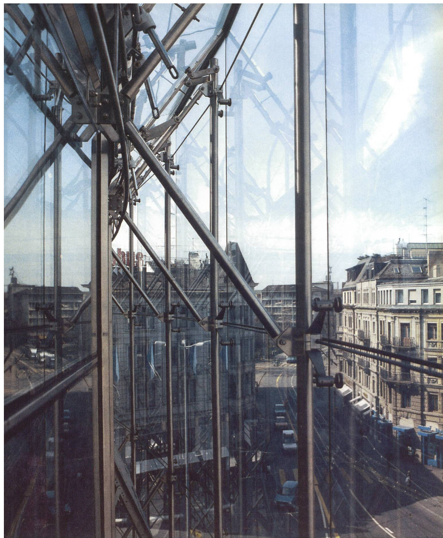
Theo Hotz, Löwenhof, Konstruktion für Glasfassade, Zürich, 1989–1993. Hubertus Adam, Ulrike Jehle-Schulte Strathaus, Philip Ursprung. Theo Hotz Architecture 1949–2002. Zürich 2003
