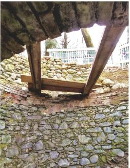
Fig. 4 Veduta dall'alto durante lo sgombero dell'interno: si riconoscono il restringimento del vano inferiore, intonacato con malta di cemento, una delle travi di metallo su cui poggiava il pavimento e l'intonaco a calce della camera superiore.
