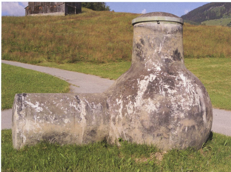
Der kleinste Schutzbau unter dem Boden: freigelegter Kugelbunker in Mompé Medel, Disentis/ Mustér GR. Foto ADAB-Inventar, Thomas Bitterli
