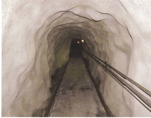
Mit Spritzbeton (Gunit) ausgekleideter Zugangsstollen im Infanteriewerk Toveyres, Lavey-Morcles VD. Foto ADAB-Inventar, Thomas Bitterli
