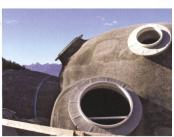
Im Schnitt ist deutlich erkennbar, wie sich das Amden-Haus sanft ins Gelände einfügt (links oben). Vor der Erdüberdeckung: der Rohbau mit der Schalen-Spritzbeton-Konstruktion, die anschliessend mit Polyurethanschaum isoliert wird (Bilder rechts). © Atelier Werner Schmidt GmbH
