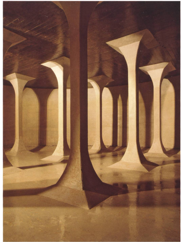
Das leere Wasserreservoir Scharten 2 in Wettingen – hier fotografiert während einer Revision – wurde 1947 erbaut und umfasst ein Volumen von 1400 Kubikmetern. Es wurde im Jahr 2013 ausser Betrieb genommen. Foto Silvio Maraini, 2011
