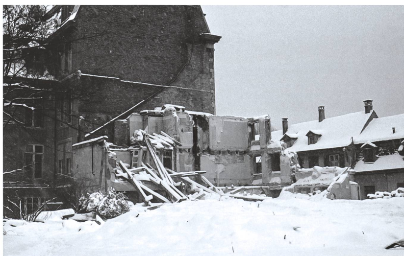
Abb.9 Hebelstrasse 12 während des Abbruchs. © Kantonale Denkmalpflege Basel-Stadt, Foto Rolf Brönnimann
