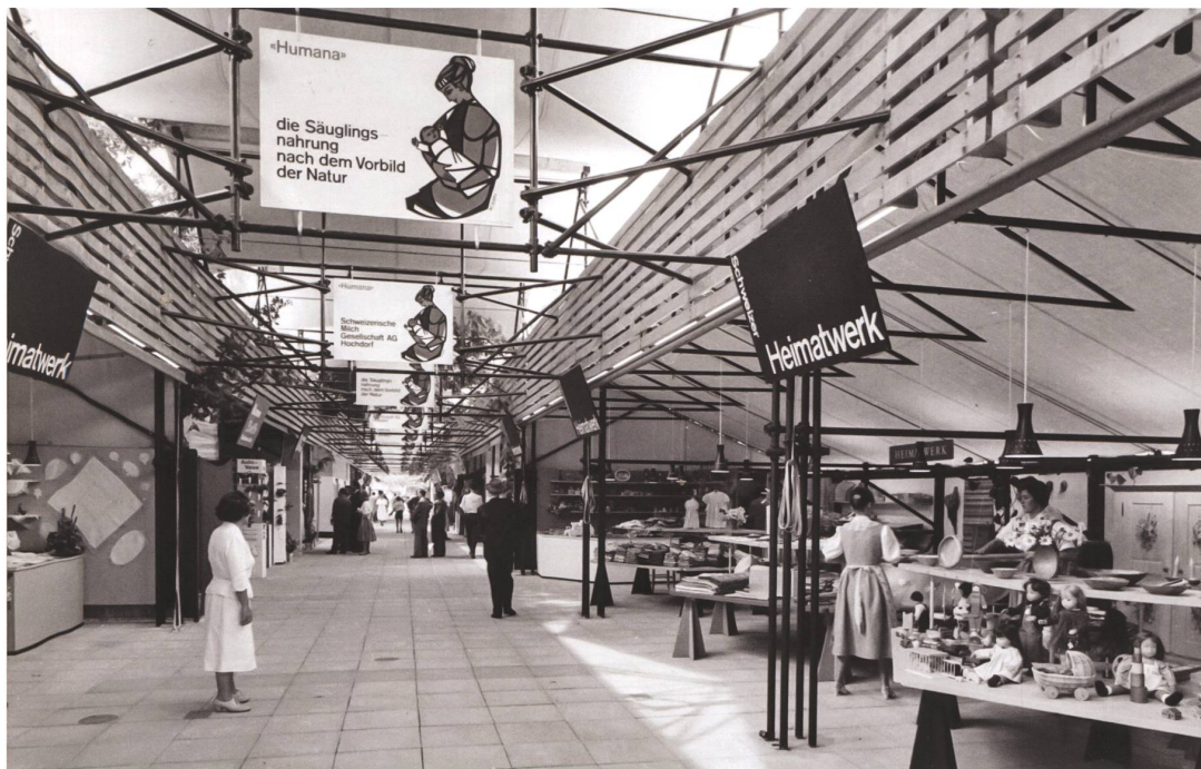
Die Ladenstrasse von Ruth Lanners-Oldani und Beate Schnitter mit modularem Blitzgerüstsystem und Leinwandplanen (gta Archiv)
