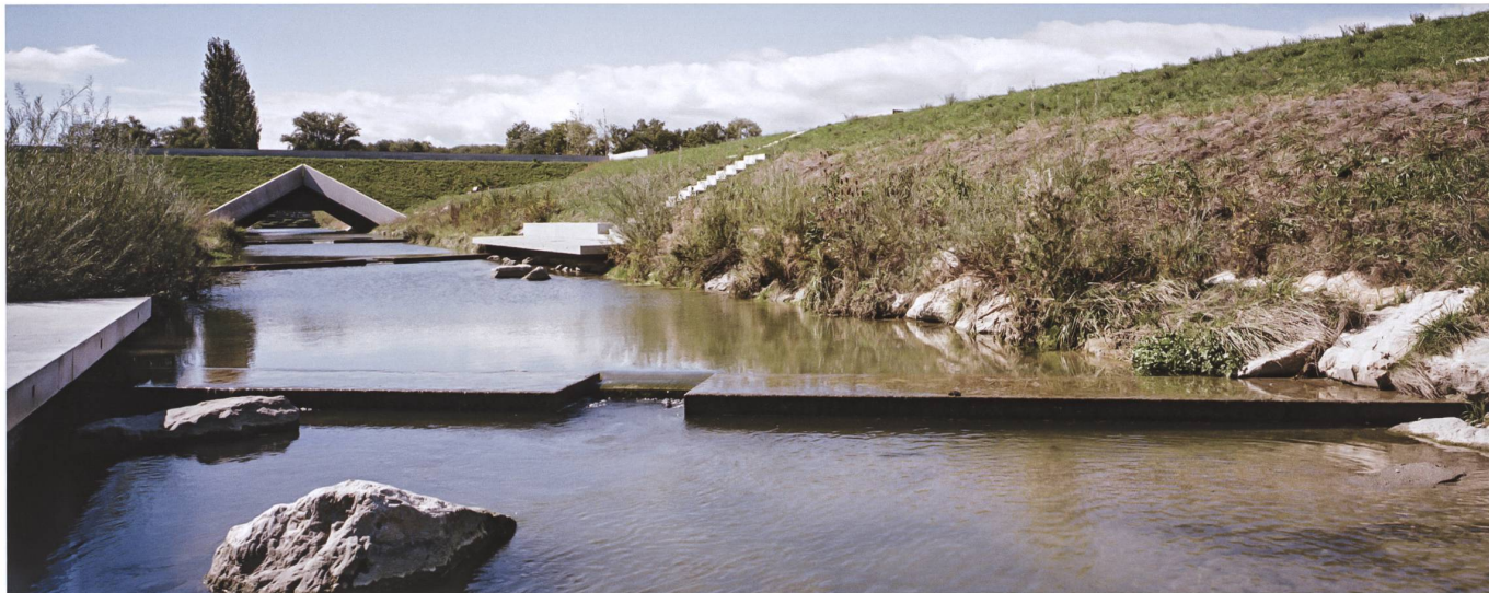
Erweiterter Aire-Kanal mit Treppen und Stufen. © ADR Atelier Descombes Rampini SA Genève, Foto Jacques Berthet
