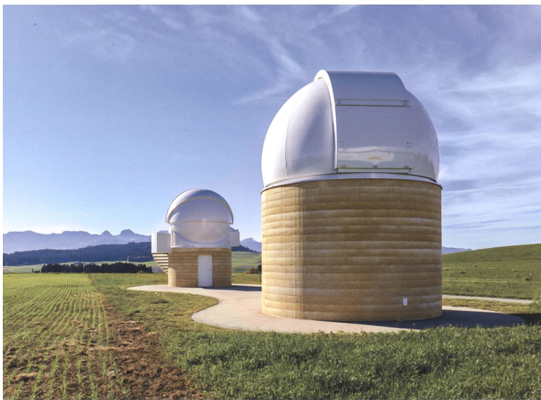
Sternwarte Zimmerwald: Die beiden neuen, futuristisch anmutenden Kuppelbauten loten präzise den Abstand zur bestehenden Anlage aus. Die Stamped-beton-Ummantelung kontrastiert farblich mit den beiden Kuppeln (links oben). Die Teleskope stehen auf einem unabhängigen Sockel, damit die Gebäudeschwingungen die Messungen nicht beeinträchtigen (rechts). Fotos Michael Peuckert
