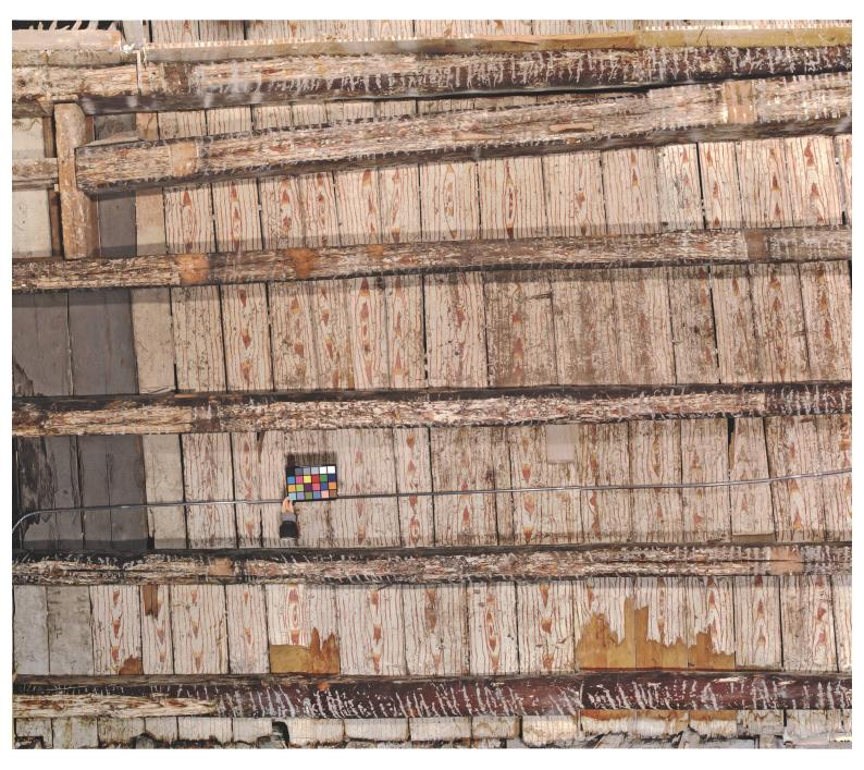
aus einem mit proteinhaltigem Bindemittel gebundenen Kalk. Die Maserierung selbst ist in freier Malerei in situ mit einem roten und einem gelben Ocker gefasst.
