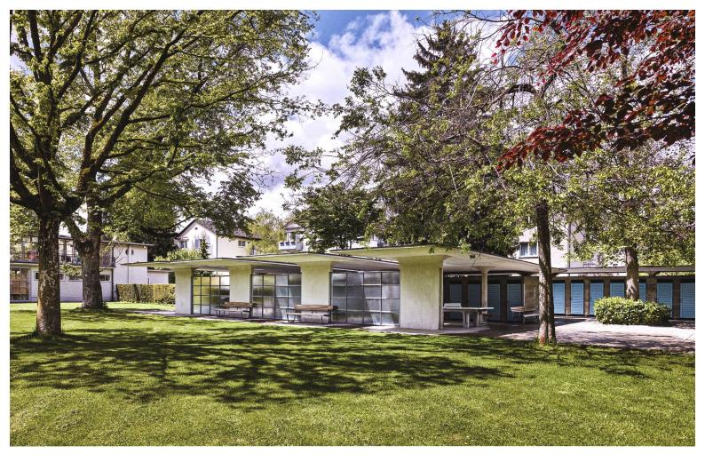
Teil der «Umkleidelandschaft»: Zwei Dächer mit kammartigen Einbuchtungen, auf schmale Wandstücke und Pilzstützen gelegt, überfangen Tischtennisplatten und Riegel von Einzelgarderoben. Foto Dirk Weiss
