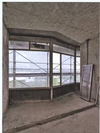
Aktueller Umbau: Die energetische Sanierung der denkmalgeschützten Fassaden ist eine Herausforderung, die nur mithilfe einer nach hinten verschobenen, zusätzlichen Glasebene gelöst werden kann. Fotos Veronica Mayer
