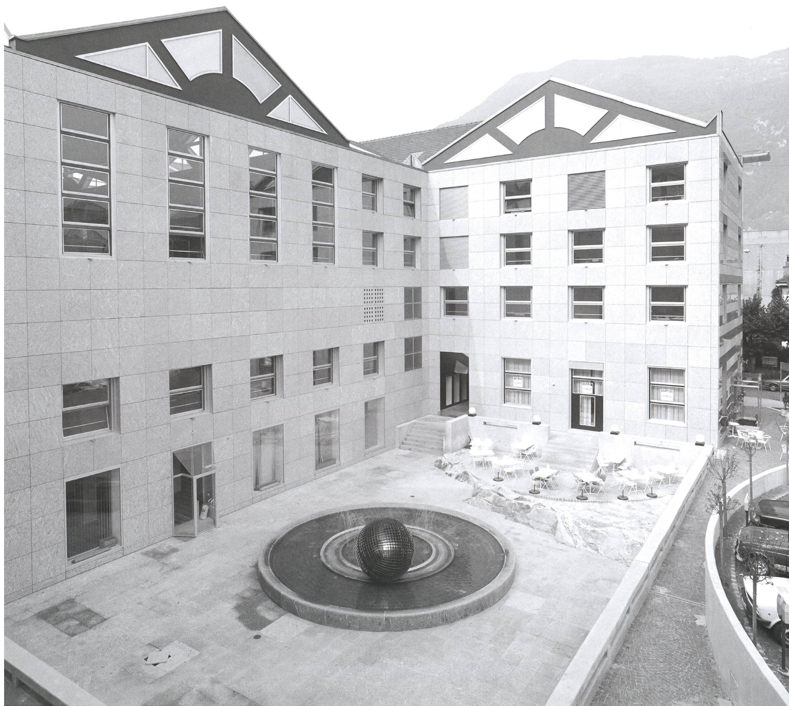
Posta centrale, Bellinzona (Arch. Angelo Bianchi, Aurelio Galfetti, Renzo Molina, 1977-1985). Pierino Selmoni, Fontana mobile , 1985, acciaio, cromo e granito della Calanca. Foto Massimo Pacciorini-Job, Giubiasco
