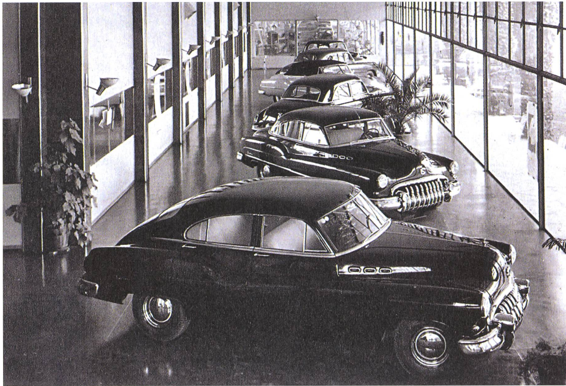
Ausstellungsraum im GM-Verwaltungsgebäude von 1936 (Architekt: Rudolf Steiger, Ingenieur: Carl Hubacher), Foto: Anfang 1950er Jahre. Quelle: Märki 2010, S. 123
