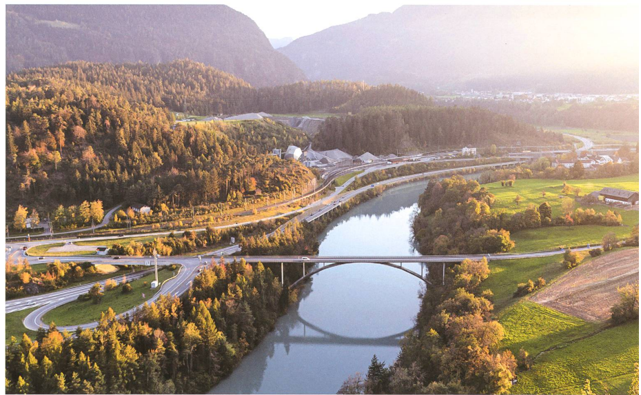
Entlang der San-Bernardino-Strasse (N13) realisierte Christian Menn eine ganze Reihe von Stabbogenbrücken, die aufgrund ihrer besonders schlanken und eleganten Konstruktionen für sein Schaffen emblematisch wurden: hier die als Anschluss an die Autobahn realisierte Rheinbrücke Tamins von 1963, die sich an landschaftlich sensibler Stelle unmittelbar nach der Vereinigung von Vorder- und Hinterrhein über den Fluss spannt
