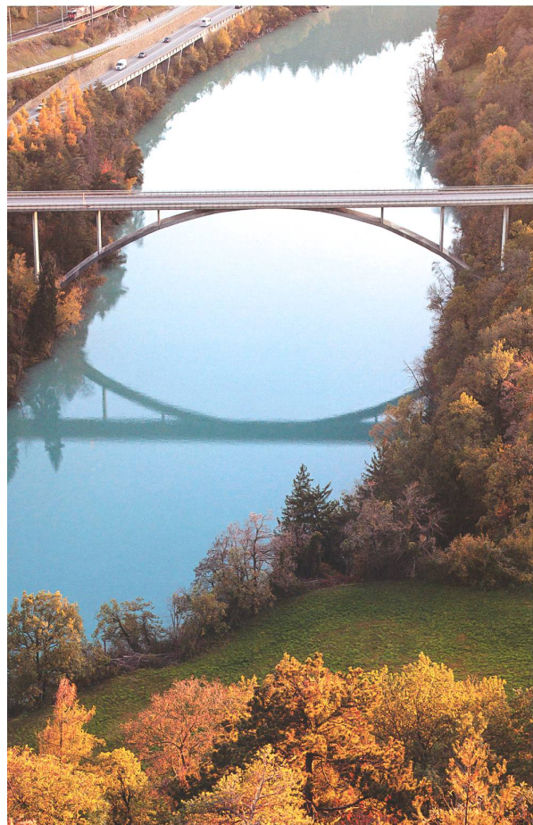
Entlang der San-Bernardino-Strasse (N13) realisierte Christian Menn eine ganze Reihe von Stabbogenbrücken, die aufgrund ihrer besonders schlanken und eleganten Konstruktionen für sein Schaffen emblematisch wurden: hier die als Anschluss an die Autobahn realisierte Rheinbrücke Tamins von 1963, die sich an landschaftlich sensibler Stelle unmittelbar nach der Vereinigung von Vorder- und Hinterrhein über den Fluss spannt
