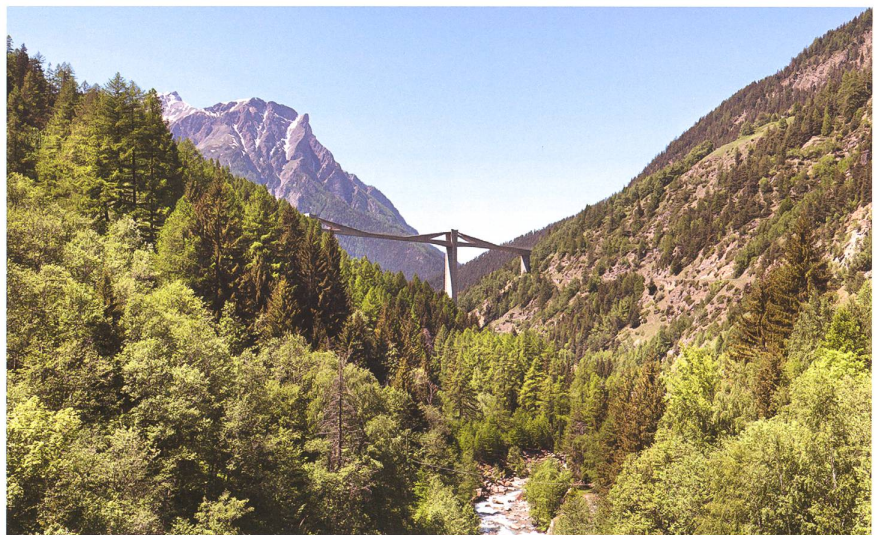
Die 1977–1980 realisierte Ganterbrücke an der Simplon-Nordrampe fällt durch ihre in markante Betonscheiben eingebetteten Kabelfächer auf. Diese sollten angesichts der grossen Spannweite und der ausserordentlichen Pfeilerhöhen ein steifes Tragsystem gewährleisten und die Spannkabel gleichzeitig vor Korrosion schützen
