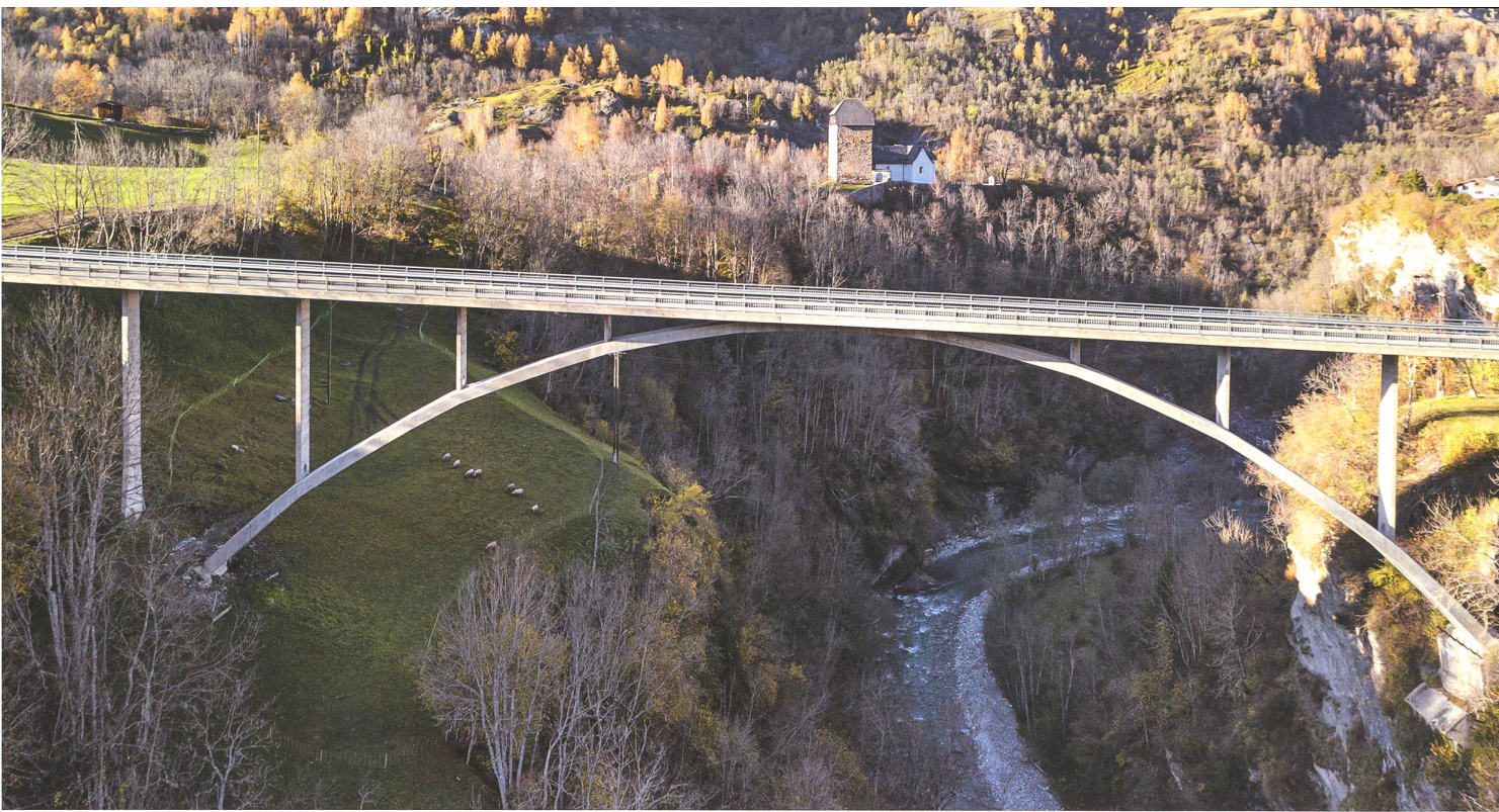
In der an der San-Bernardino-Strasse angewandten Technik des Stabbogens mit mittragender Fahrbahnplatte realisierte Menn 1962 auch die besonders filigran ausgebildete Surcastibrücke, die einer kleinen Nebenstrasse im Lugnez (Val Lumnezia) dient
