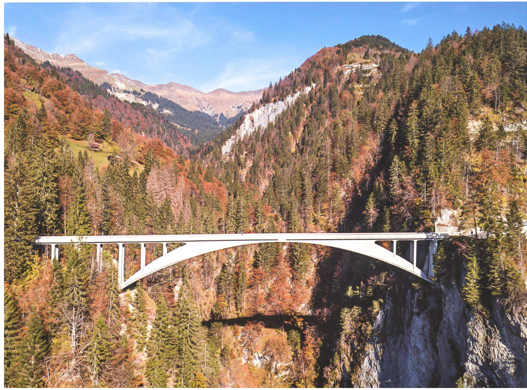
Bilder oben: Die Nanin- und die Cascellabrücke, die mit ihrer Fernwirkung in der steilen Bergflanke oberhalb von Misox (Mesocco) ein Wahrzeichen der San-Bernardino-Route bilden, wurden 1966–19 nacheinander auf demselben Lehrgerüst erstellt
