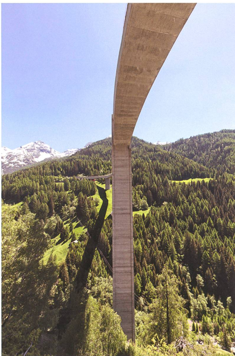
Die 1977–1980 realisierte Ganterbrücke an der Simplon-Nordrampe fällt durch ihre in markante Betonscheiben eingebetteten Kabelfächer auf. Diese sollten angesichts der grossen Spannweite und der ausserordentlichen Pfeilerhöhen ein steifes Tragsystem gewährleisten und die Spannkabel gleichzeitig vor Korrosion schützen
