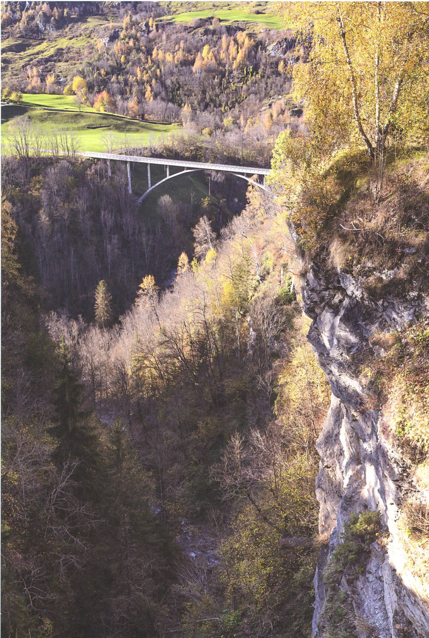
In der an der San-Bernardino-Strasse angewandten Technik des Stabbogens mit mittragender Fahrbahnplatte realisierte Menn 1962 auch die besonders filigran ausgebildete Surcastibrücke, die einer kleinen Nebenstrasse im Lugnez (Val Lumnezia) dient
