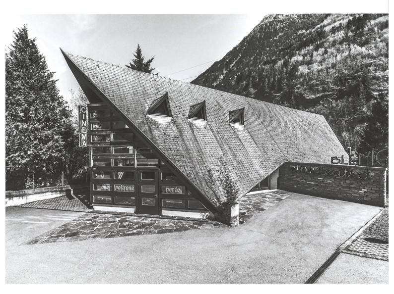
Fig. 2 Vista del fianco sud. La fotografia evidenzia la linea orizzontale del colmo e la geometria complessa delle falde del tetto. © Ph. Roberto Conte, Milano
