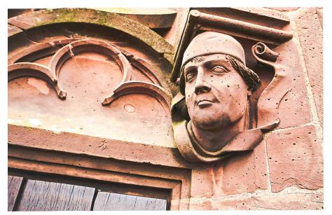
Abb.11 Selbstportrait des Hans Nussdorf mit seinem Meisterzeichen am Türsturz des ersten Treppentürmchens an der Nordfassade des Martinsturms. Kopfkonsole und Türsturz bestehen aus einem Werkstein. Foto Dirk Weiss, 2019
