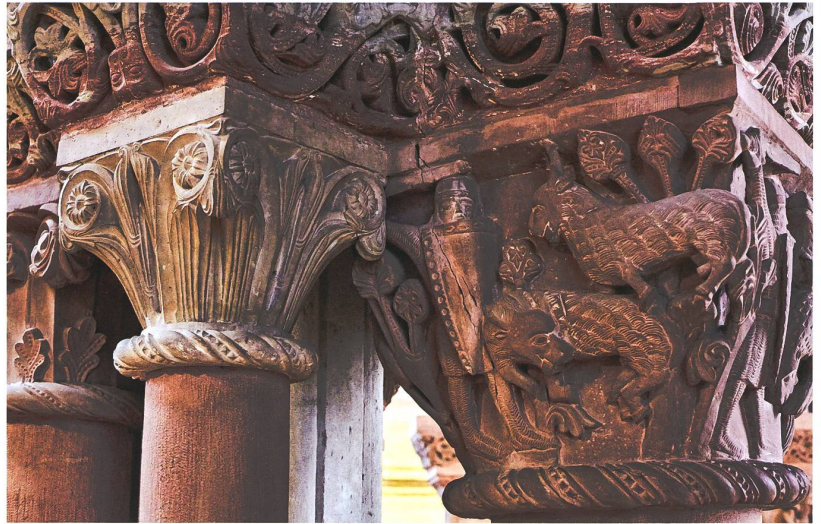
Abb. 5 Riss und Beschädigung am Figurenkapitell des Chorpfeilers (c) sowie seitliches Pflanzenkapitell bestehend aus unterschiedlich kalkhaltigem Stein. Foto Dirk Weiss, 2019
