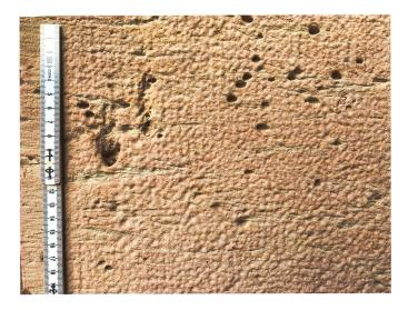
Abb. 2a Besonders auffällig ist ein hellgrauer bis weisslicher, feinkörniger, oft grünlich geflaserter und bisweilen durch kleine, kreisrunde Löcher geprägter Flasersandstein, der die romanischen Bauteile an der Westfassade des Georgs- und teilweise des Martinsturms kennzeichnet. Foto Bianca Burkhardt, 2019
