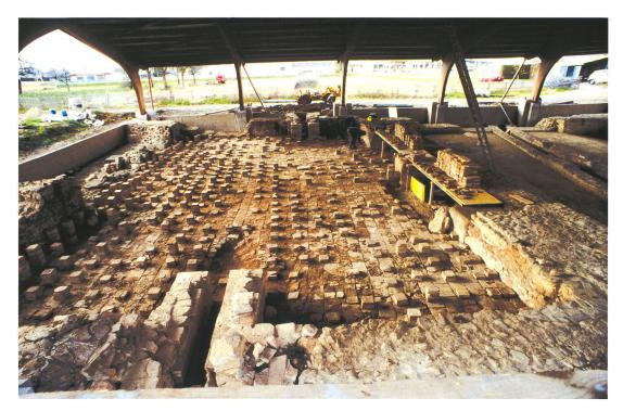
Fig. 2 Avenches (VD), insula 29, thermes du forum, salle tempérée (tepidarium), vestiges des piles de carreaux de terre cuite du chauffage par le sol (hypocauste). Photo Site et Musée romains d'Avenches SMRA
