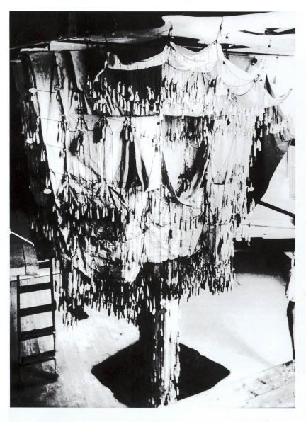
Abb. 2 Antoni Gaudí, Hängemodell, das zur Formfindung der Kirche der Colònia Güell gebaut wurde, ca. 1900. Foto z.V.g.
