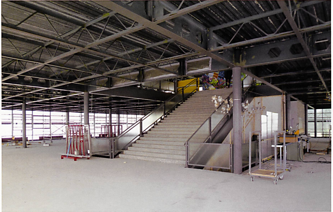
Abb. 6 Aktuelle Innenaufnahme des Schulgebäudes Auen 1 während der Rückbaumassnahmen. © Jessenvollenweider
