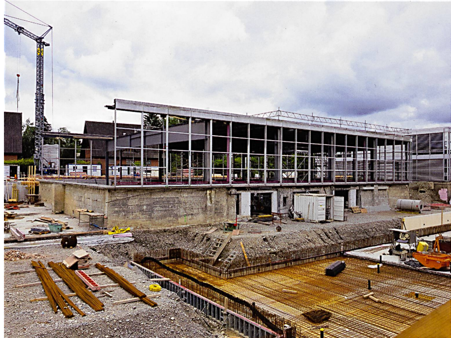
Abb. 8 Aktuelle Aufnahme der Erweiterung der Turnhalle und der Neukonzeption der unterirdischen Nebenräume. © jessenvollenweider
