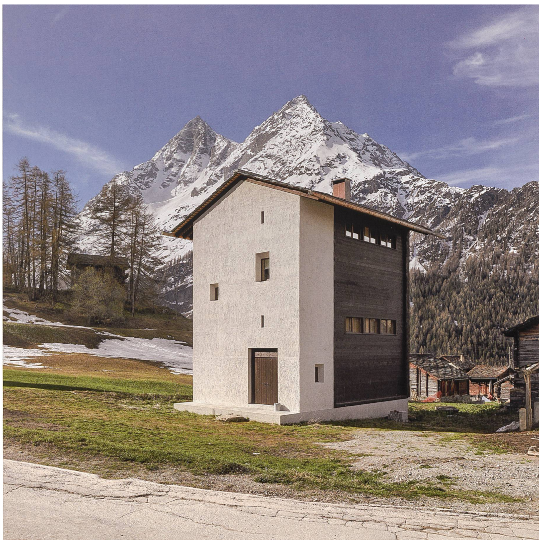
Fig. 1 Faces nord-est (en maçonnerie) et nord-ouest (en bois) du chalet Jaccaud-Zein. Une grosse pierre calcaire fait office de marche d'entrée pour atteindre le socle. Les deux fenêtres meurtrières ventilent les salles de bain. © Dirk Weiss, 2018
