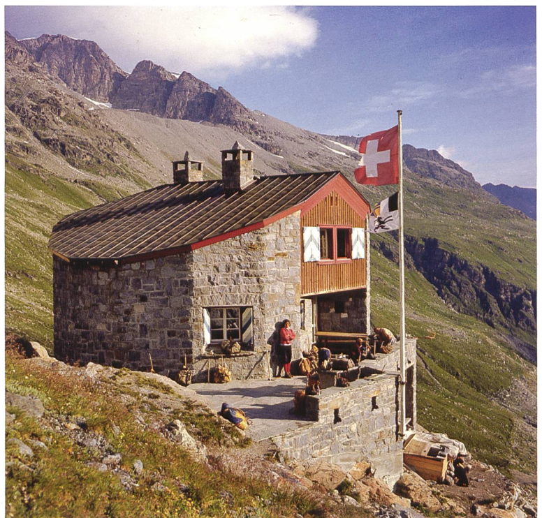
Abb. 9 Bordierhütte im Mattertal VS, 1927 in traditioneller Steinbauweise des 20. Jahrhunderts erbaut. Aufnahme um 1960 (Fotoarchiv Kunstanstalt Brügger, Meiringen. Alpines Museum der Schweiz, Bern)
