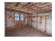
Ost- und Südwand der Dachkammer im «Höfli» in Obstalden (Dorf 8). Gemalte Säulen tragen einen marmorierten Architrav, der mit dem obersten, leicht vorkragenden Balken der Bohlenwände zusammenfällt. Malerei aus der Bauzeit um 1700. Foto Urs Heer, 2010
