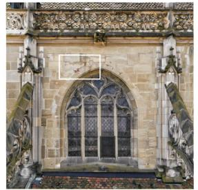
Von Ersatzmassnahmen verschont, ist das Obergadenfenster 90 an der Südseite des Chores eine beredte Quelle der Baugeschichte. Der mittelalterliche Bestand zeigt Spuren verschiedener Restaurierungsphasen (unten: Gesamtansicht, oben: Detailausschnitt, 2016). © Berner Münster-Stiftung
