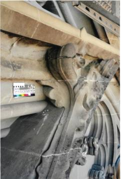
Die Fassade des Turmvierecks Nord war 1963 massiv überarbeitet und in grossen Teilen neu erbaut worden. Anlässlich eines Bauservice 2014-2015 wurde der Bauteil gereinigt, gefestigt, ergänzt und mit kleinen Blechabdeckungen vor Wasser geschützt. Mit kleinen Eingriffen bzw. Restaurierungsund Instandhaltungsarbeiten in relativ kurzen Abständen ermöglicht das Berner Modell Substanzerhalt, Lebensverlängerung und Kosteneinsparungen. © Berner Münster-Stiftung
