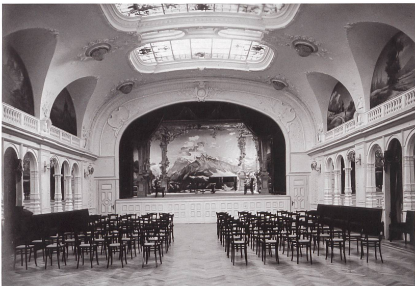
Abb. 11 Grindelwald BE, Hotel Bär, Festsaal nach dem brandbedingten Wiederaufbau von 1894. Hotel 1941 abgebrannt (Sammlung des Autors)
