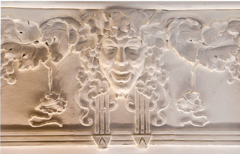
Brasserie de l'Inter. Le plafond d'origine après enlèvement du faux plafond et avant restauration. Office cantonal de la culture, Porrentruy
