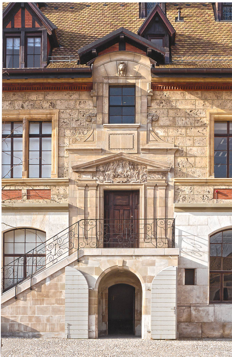
Collège Calvin, entrée principale, construite entre 1558 et 1562. Photo © Olivier Zimmermann, 2015
