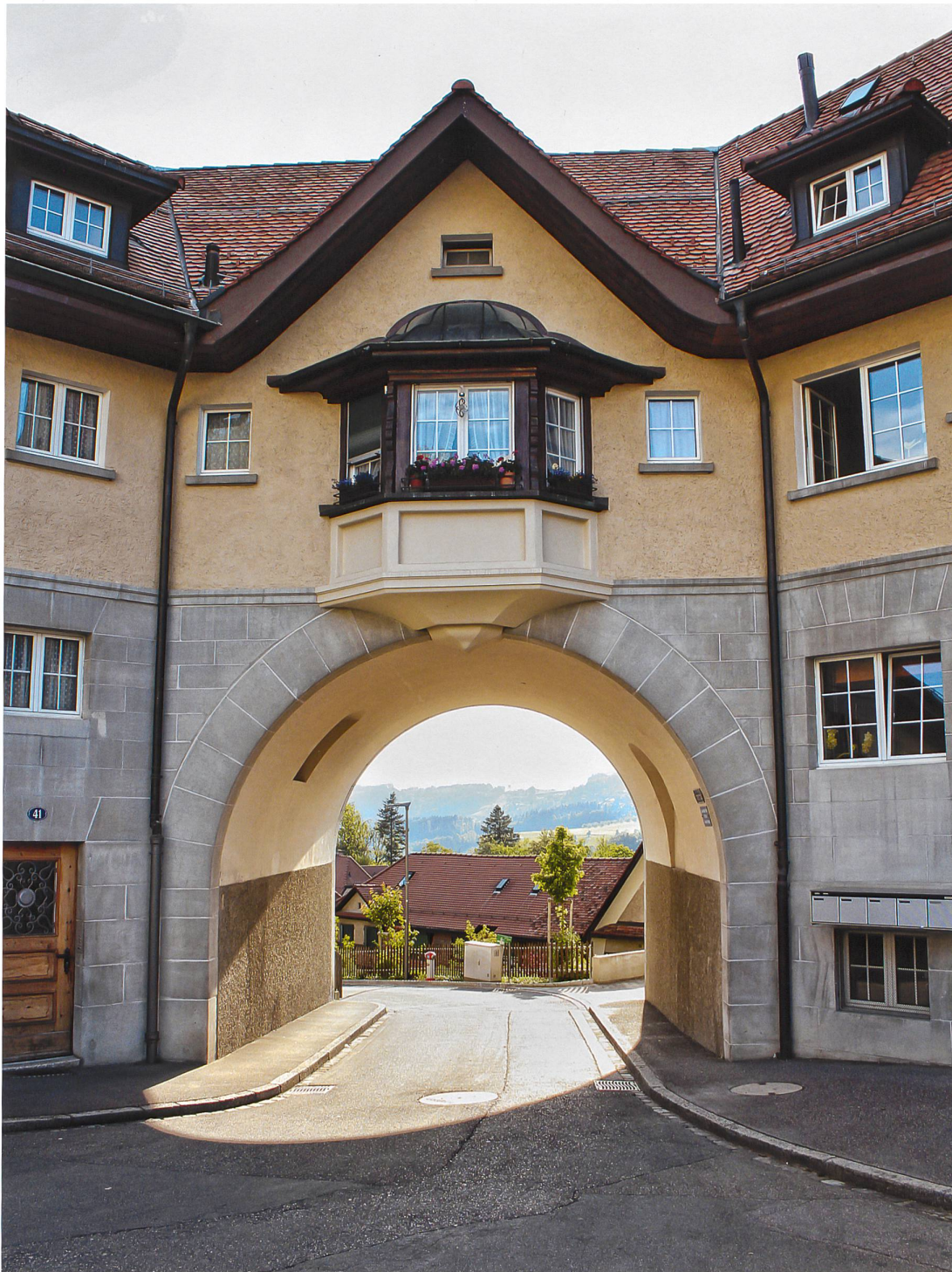
Genossenschaftssiedlung Schoren, St. Gallen, 1911–1913. Das Eingangstor in das Eisenbahndorf. Foto René Uhlmann
