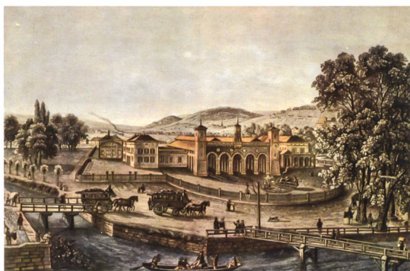
Ansicht des Bahnhofs Zürich von der Limmatseite, 1847. Baugeschichtliches Archiv der Stadt Zürich
