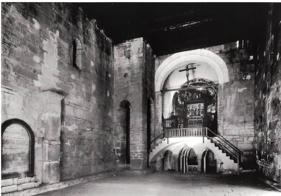
Abb. 7 Giornico, romanische Kirche von San Nicolao, Blick zum Presbyterium, Zustand vor der Restaurierung. Foto: Ufficio Beni Culturali Bellinzona
