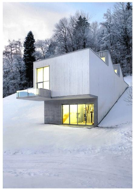
Die Beleuchtung funktioniert in der Tiefe des Raums vor allem über die Fenster im Scheddach, also eigentlich einer Fabrikdachform, die aber schon lange auch für Ateliers verwendet wird.
