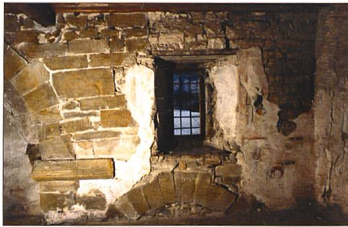
Abb. 230 Langenbruck. Ehemaliges Kloster Schöntal. Klosterkirche, Innensicht der Ostwand. Oberhalb des Zwischenbodens sind der mittlere Apsidenbogen samt Kämpfer sowie die oberen Bogenkellsteine der rechten Nebenseite zu erkennen. Rechts davon hat sich – heute unter dem Putz verborgen – das Wandmalereifragment eines bärtigen Heiligen erhalten, das um 1450 datiert. Aufnahme um 1989, ABL.
