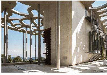
Visualisierter Kräftefluss als Gestaltungselement: Das Dach verbindet die Stützen und ist nur dort geschlossen, wo dies statisch sinnvoll ist. Foto Adrien Barakat
