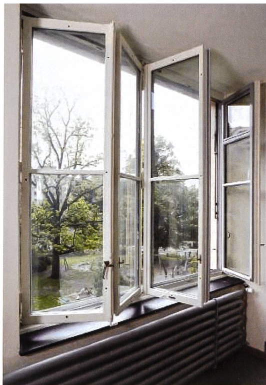
Scuola Dula (1931-33), Lucerna, arch. Albert Zeyer. Sistema dei serramenti scorrevoli a libro e sopraffuso su una delle ante, dopo il restauro del 2008 dello studio di architettura Lengacher Emmenegger. Foto Kantonale Denk- malpflege Luzern, Theres Bütler
