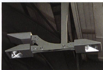
Die neue Beleuchtung der Bahnhofshalle St. Gallen (Sanierung Architekten-Kollektiv, Winterthur): Indirektes Licht hebt die historische Hallenstruktur sanft hervor. © Fotos R. C. Dürr/EBP
