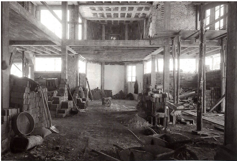
Le Corbusier, photographie prise lors du chantier de la villa Turque, La Chaux-de-Fonds, 1916. On remarque la légèreté et la «transparence» de la structure Dom-ino. © FLC / 2013, ProLitteris, Zurich
