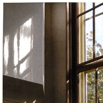
Le Corbusier, villa Turque, détail de la grande verrière du salon, avec le double châssis contenant les tuyaux de chauffage. © FLC / 2013, ProLitteris, Zurich. Photo Silvia Berselli, 2012
