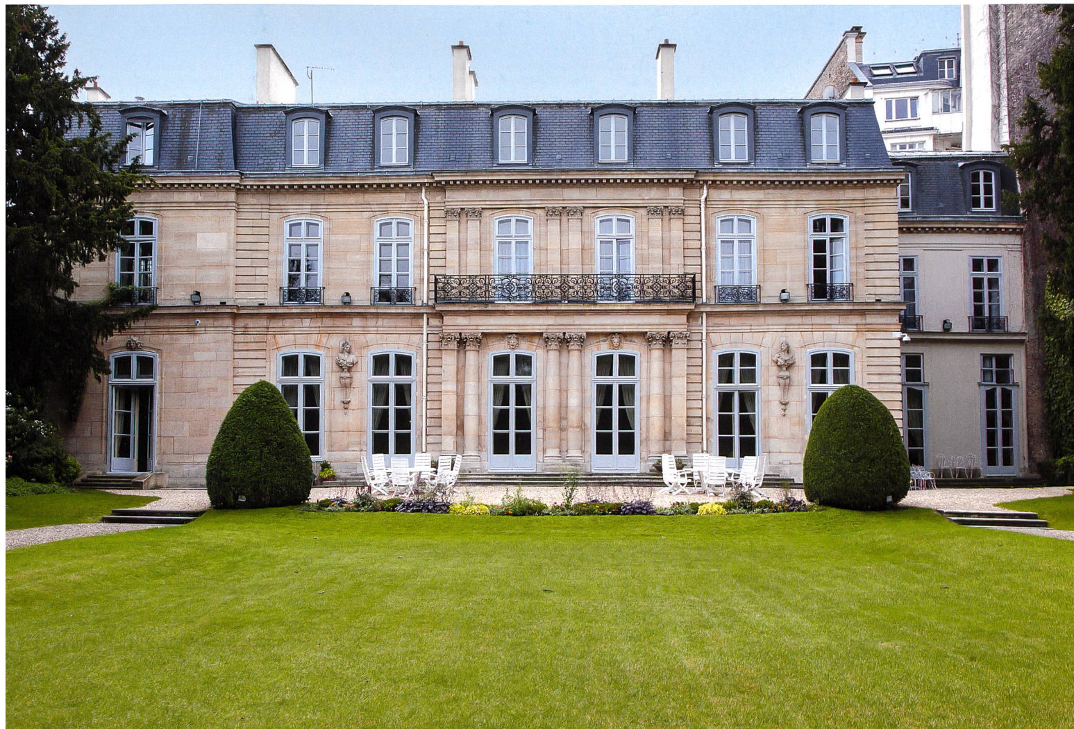
Fig. 1 L'ambassade de Suisse à Paris, vue de la façade sud côté jardins. © Bundesamt für Bauten und Logistik / Renaud Sterchi
