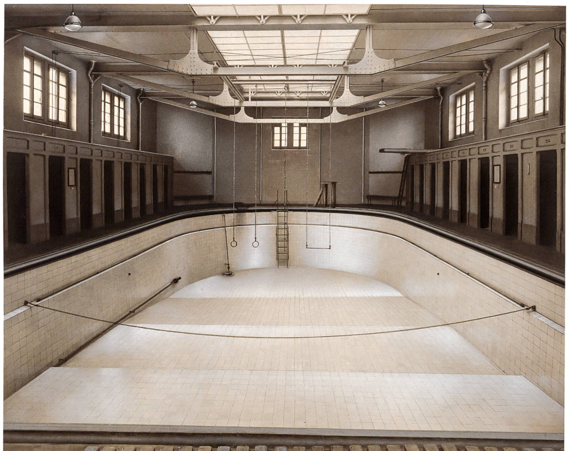
Fig. 4 Le bain-buanderie Haldimand à Lausanne (photo vers 1915, construction du bâtiment en 1893), vue du bassin vide montrant les différences de niveau et les instruments de gymnastique. La piscine comme salle de bains et salle de gymnastique. © Musée historique de Lausanne
